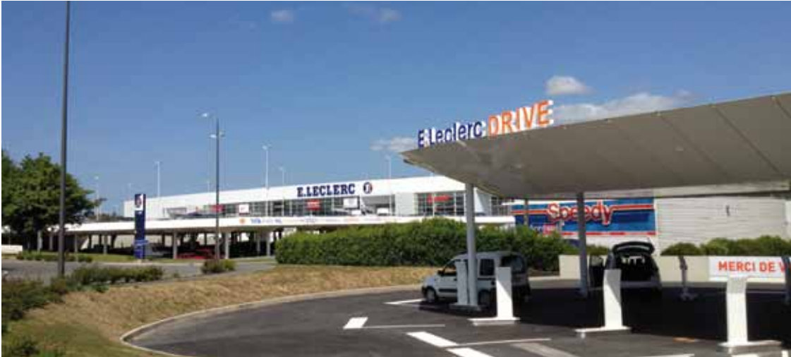
Drive accolé au E. Leclerc de Saint Grégoire
