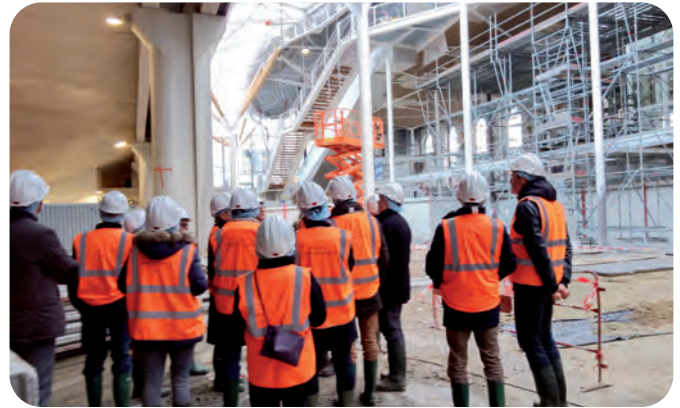
Les membres du groupe de travail « Impacts LGV » en visite au chantier de la gare.
